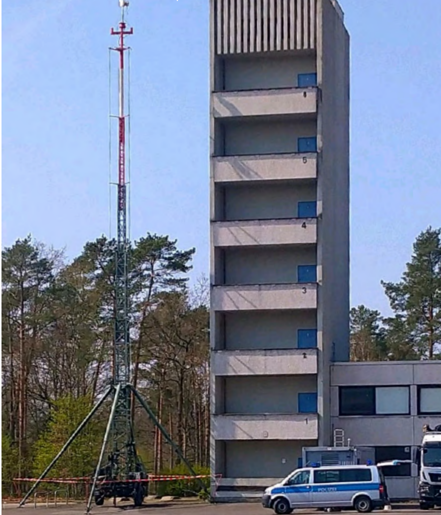
25-m-Mast mit Richtfunkspiegel und TETRA-Antenne bei der Niedersächsischen Akademie für Brand- und Katastrophenschutz | Foto: ASDN
